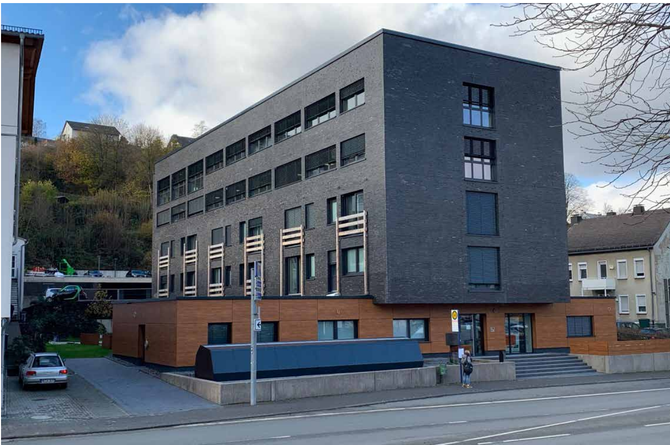
Abb. 168 Ansicht von der Straße [Quelle: ???]
