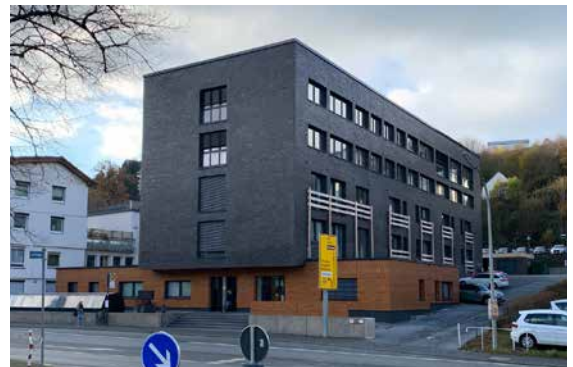
Abb. 169 Ansicht vor und nach der Sanierung [Quelle: ???]
