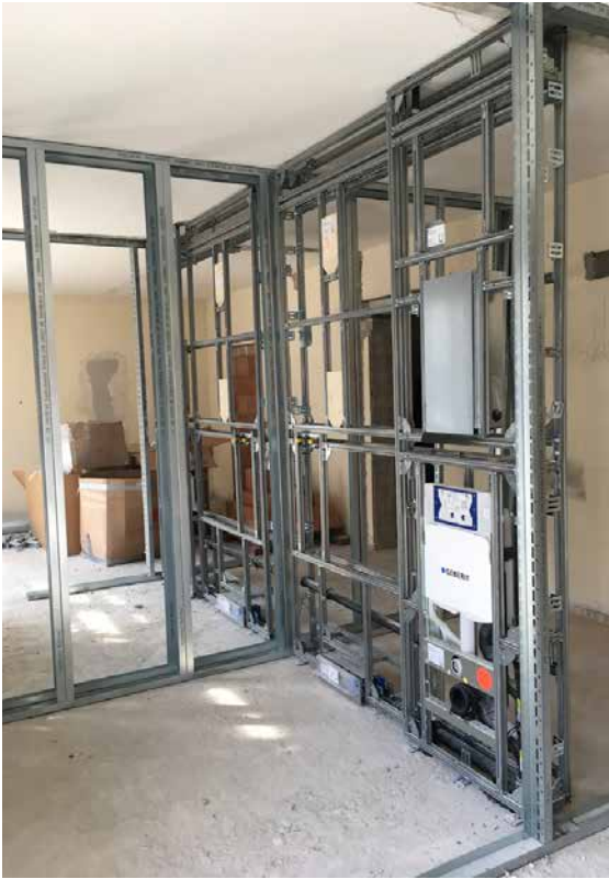
Abb. 171 Vorgefertigte Installationswand mit WC-Spülkasten, Durchlauferhitzer und Duscha Ablauf [Quelle: ???]
